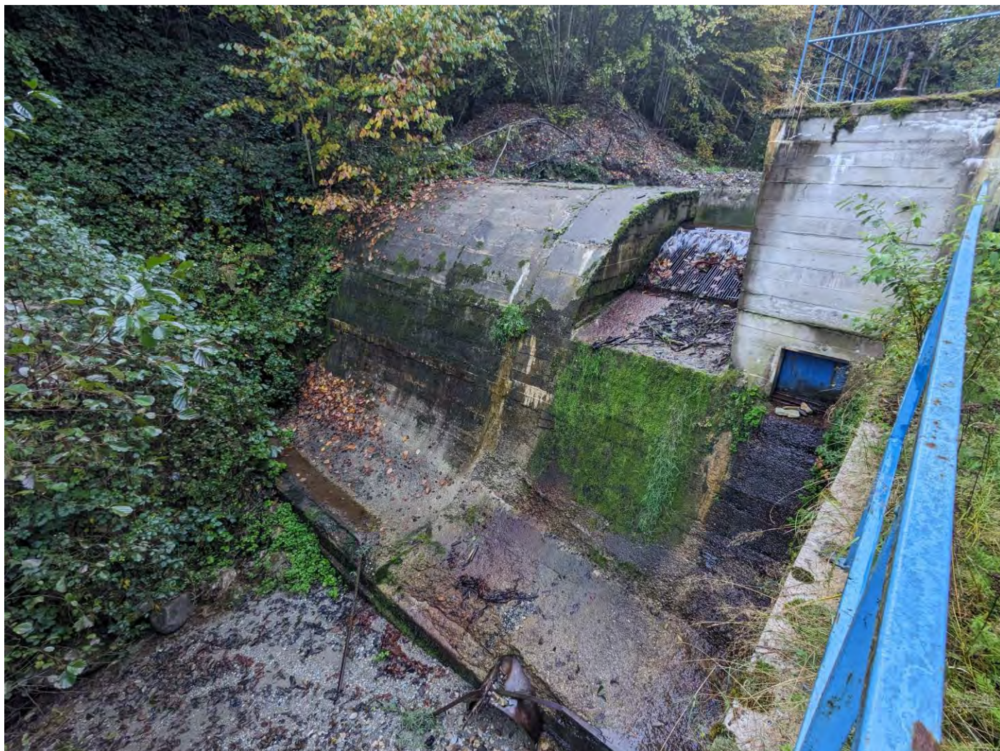
Fig. 9.3 Baraj de beton identificat pe Băuțar/Niermeș
