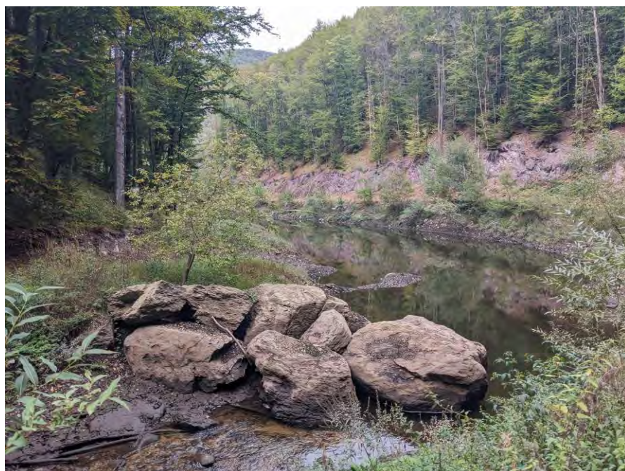
Fig. 2.6 Captare pt MHC aval sector Sacherstița
