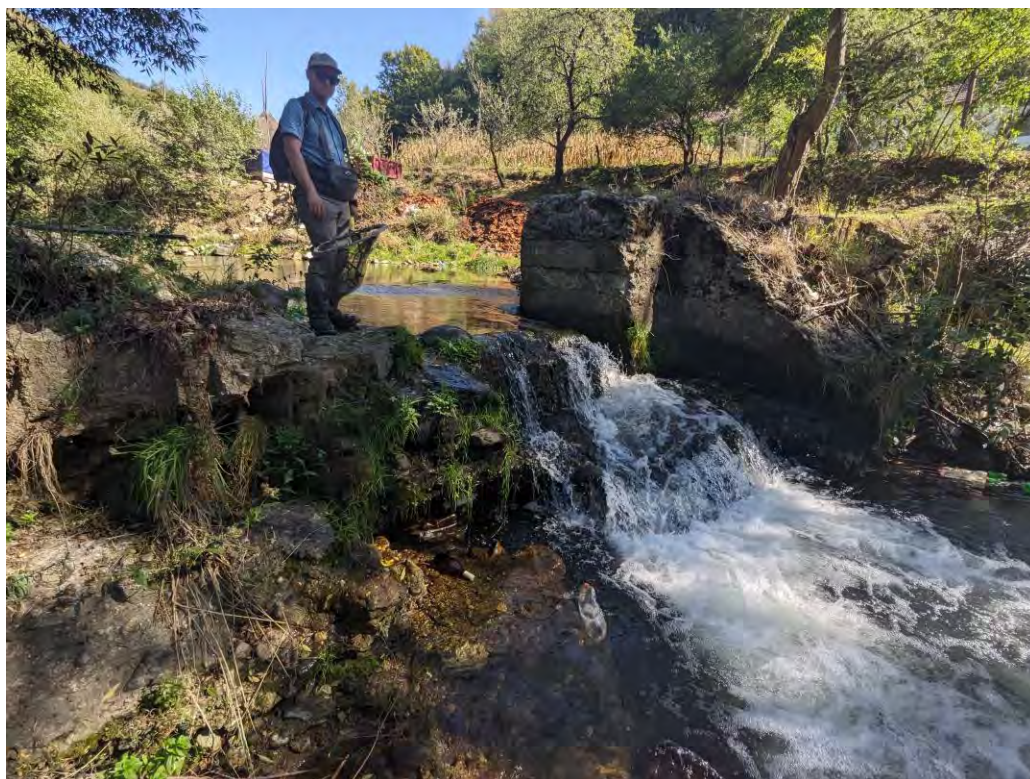
Fig. 9.1 Prag de beton identificat pe Romna
