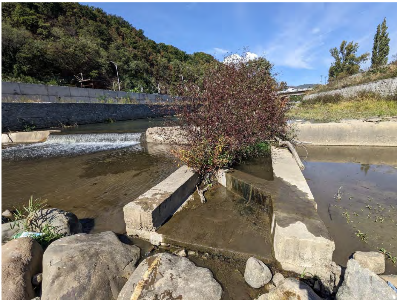
Fig. 3.1 Primul prag, cu pasaj pentru ihtiofaună nefuncțional, dintre cele peste 20 de praguri de pe Belareca, amenajat în proximitatea confluenței cu râul Cerna
