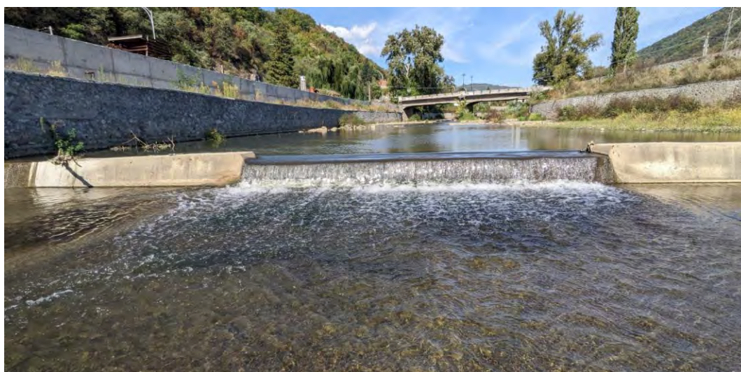
Fig. 9.0 Prag de beton identificat pe Belareca
